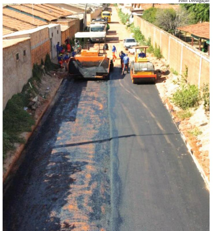
caras Anhanguera A, B e C, em uma extensão de 25.276,60 m² de pavimentação de CBUQ e execução de meio-fio e sarjetas. 6.988,06 metros, área de
